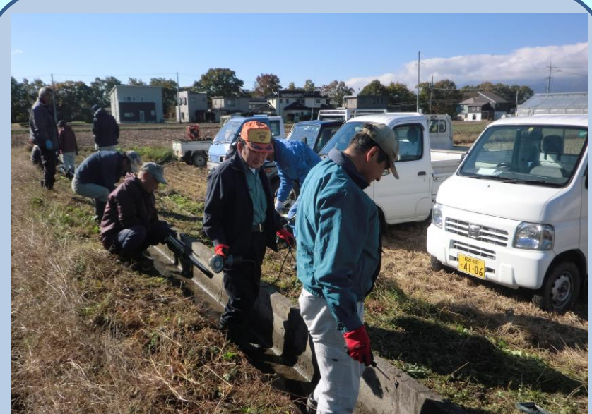
水路目地詰め補修作業
