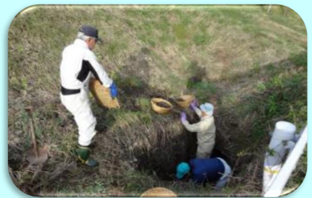
南橋水路の堰浚い作業
