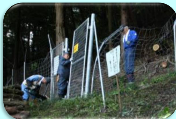
鳥獣害防護網の点検補修作業
