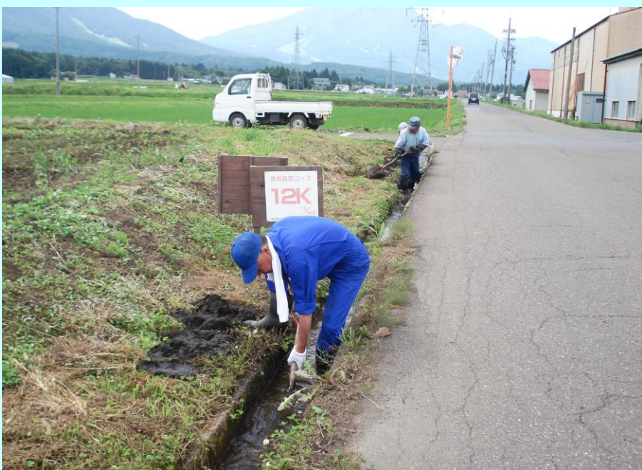
水路の泥上げ
