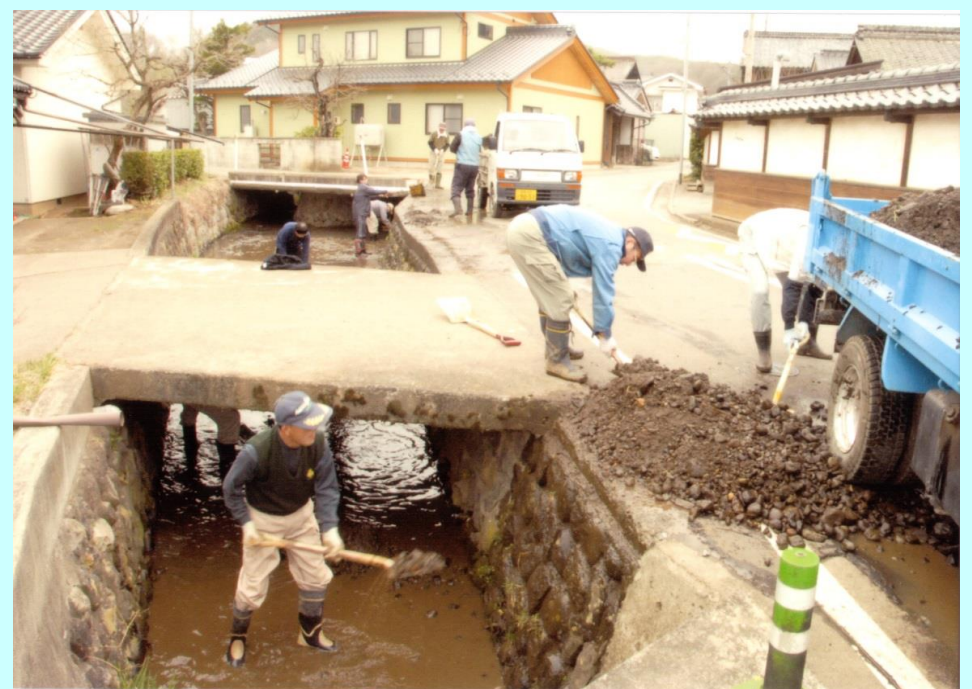
水路の土砂上げ
