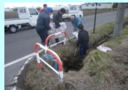
水路の泥上げ作業
