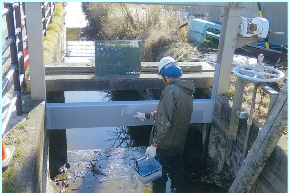
小堰に分配する水門の塗装工事
