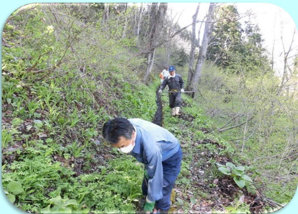
水路の泥上げ・点検
