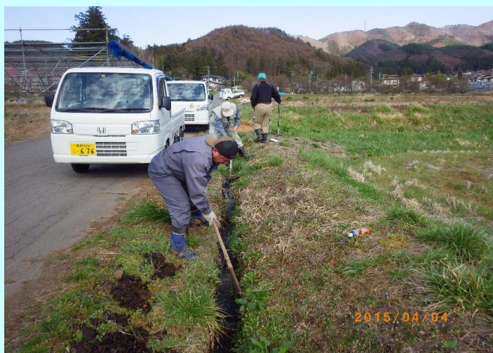
水路の泥上げ
