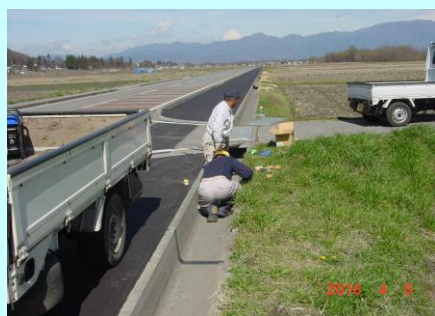
〈役員による水路漏水補修〉(4月)
