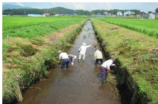
高法面の草刈作業と用排水路の清掃作業
