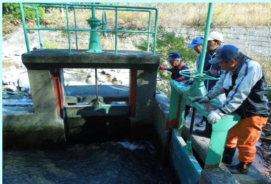
楠川水門取入れ口管理、点検、清掃等
