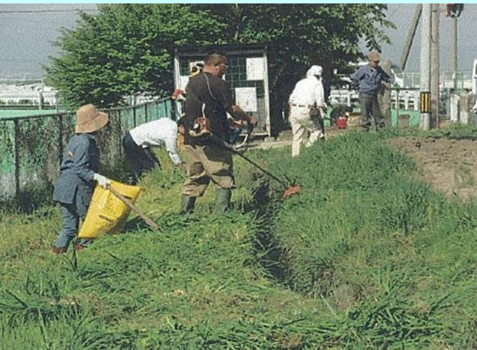
水路周りの草刈り
