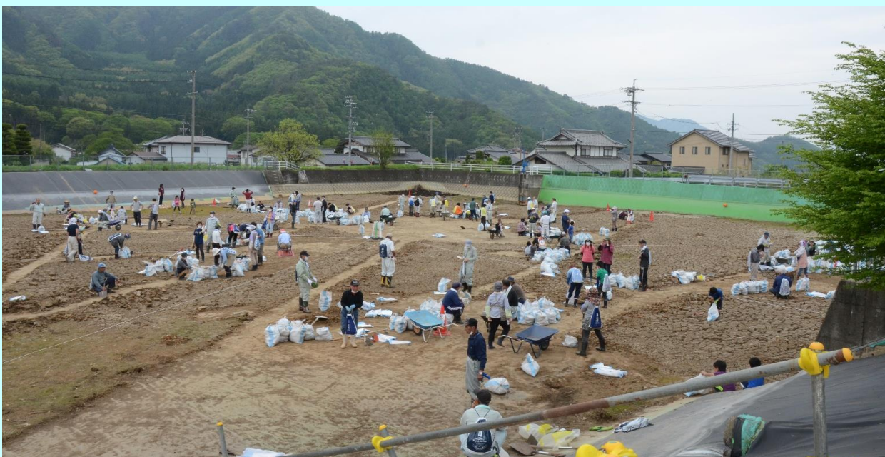
ため池の堆積土砂の除去作業
