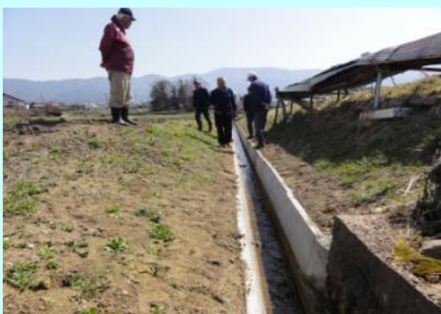
長寿命化の工事
