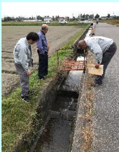
役員・施工業者との水路点検
