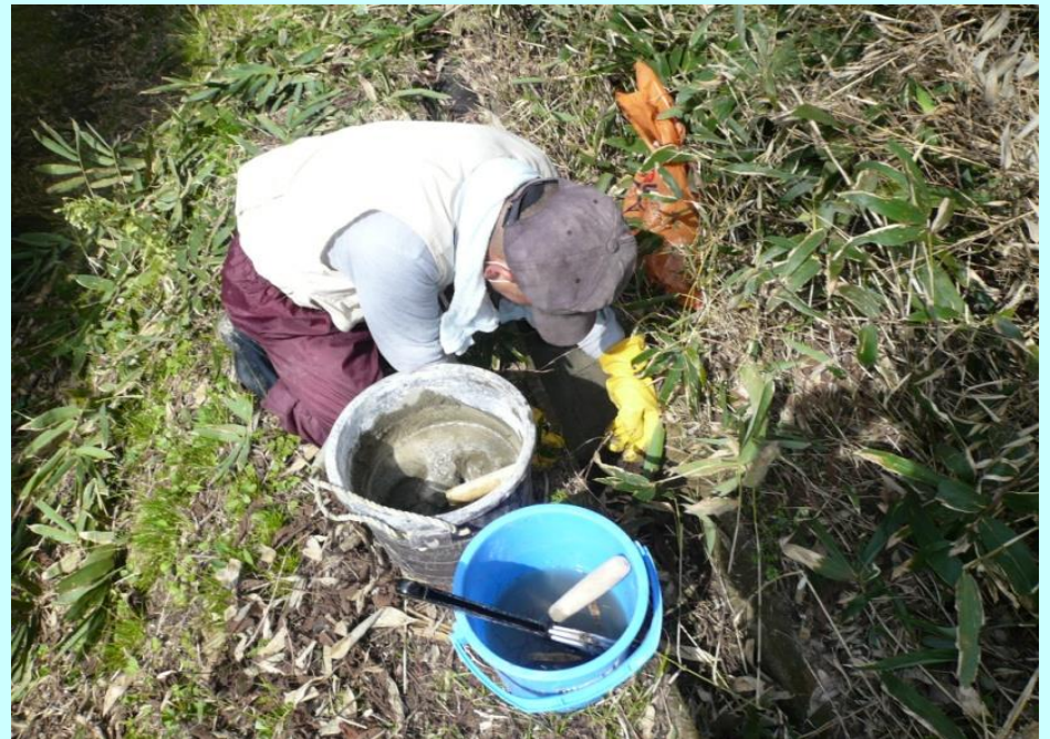
水路 コンクリートの目地詰め作業
