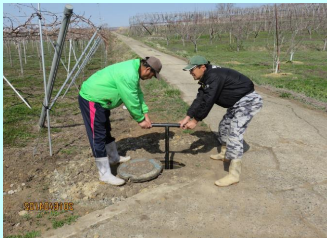
春、送水管の点検
