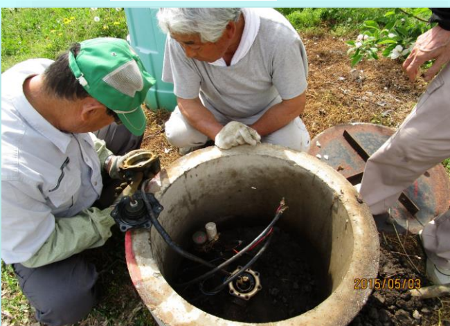
電磁弁の補修
