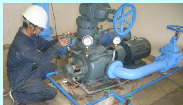
ポンプの補修
