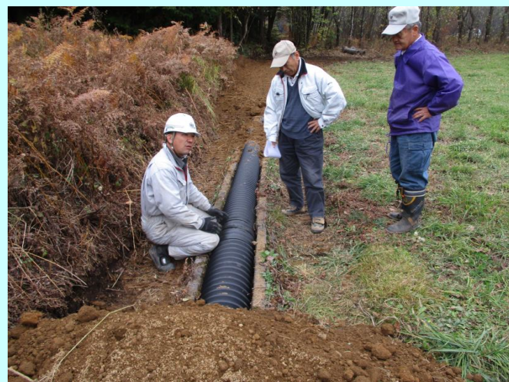
長寿命化水路工事
