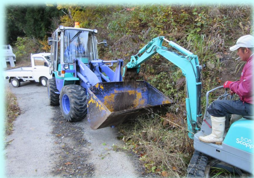
重機による柵整備
