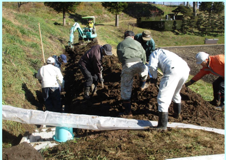
U字溝敷設工事
