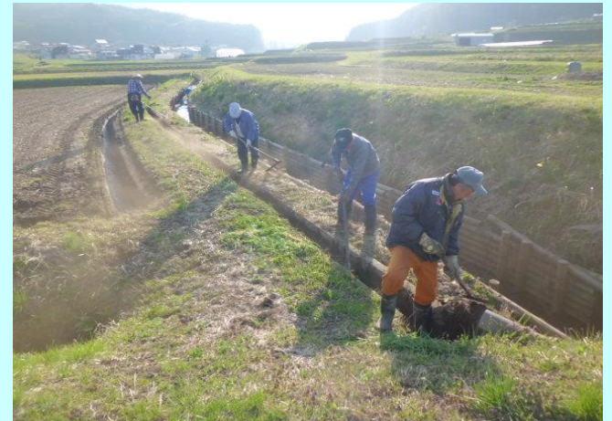
水路の泥上げ
