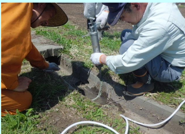
U字溝補修
