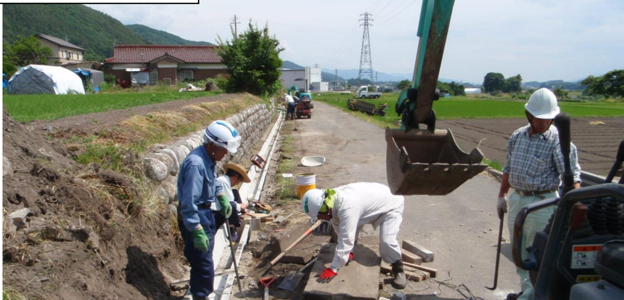
水路の更新作業を実施
