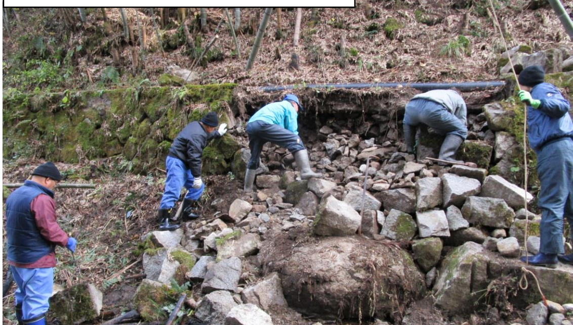
水路の補修状況（崩れた水路法面を直営施工）
