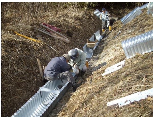
水路の補修作業
