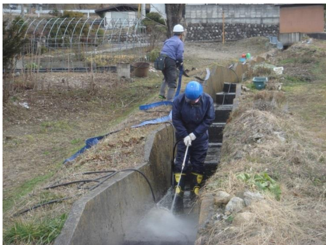
水路の目地詰めの準備
