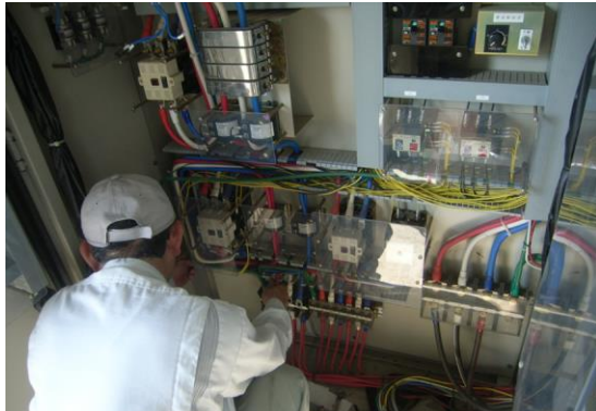
加圧ポンプの制御盤の補修（落雷被害対応）
