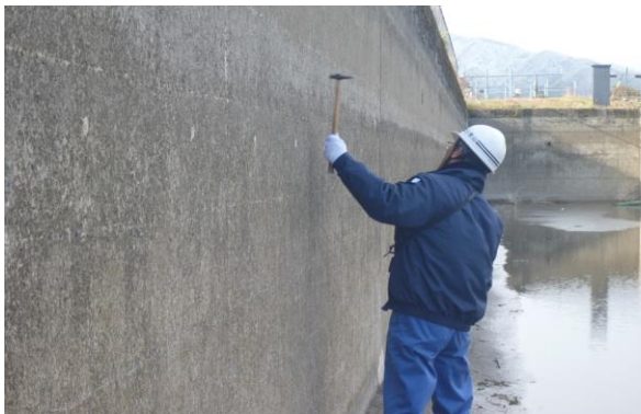
貯水槽の機能診断は大切な用水確保の必須条件
