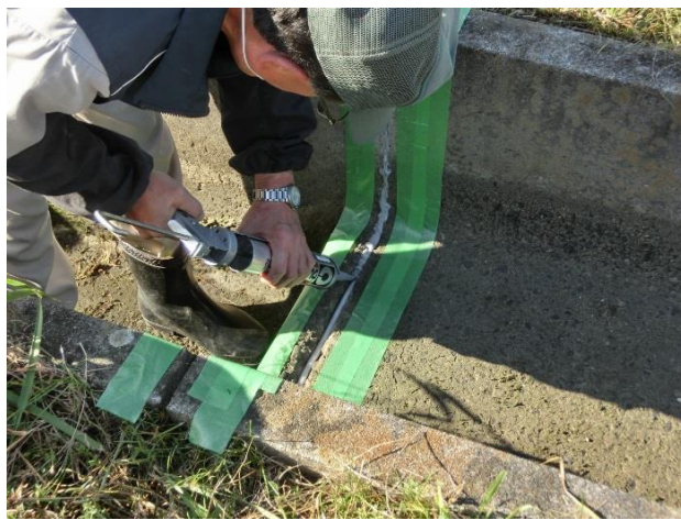
目地補修の技術研修会 作業の様子
