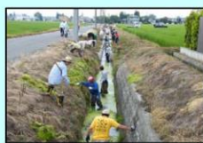
用水路の泥上げ
