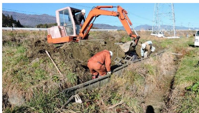
老朽化した水路の撤去
