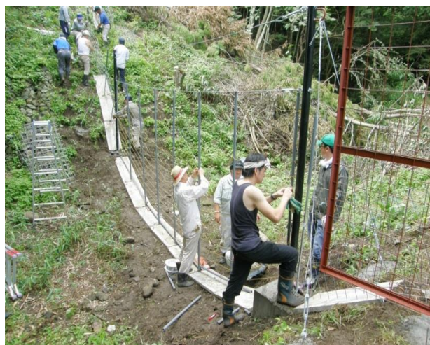
獣垣設置作業
