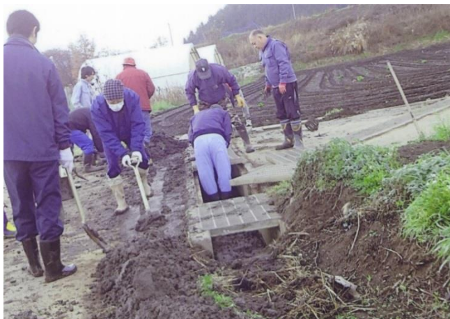
水路の泥上げの様子1
