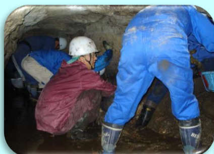
(隧道内の土砂出資作業)
