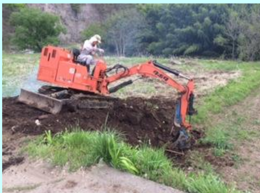
畑の取り付け道路の設置作業
