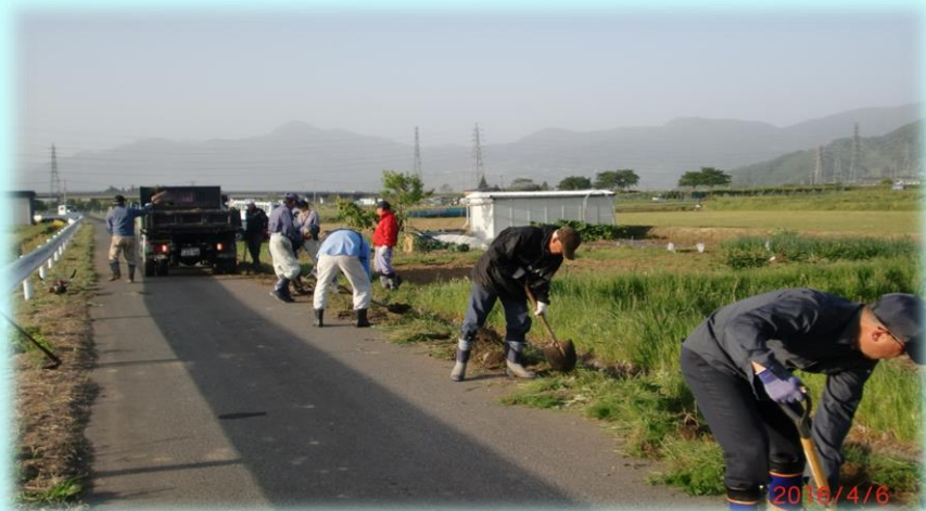
春の農作業に備え側溝の泥揚げと法面の草刈り作業
