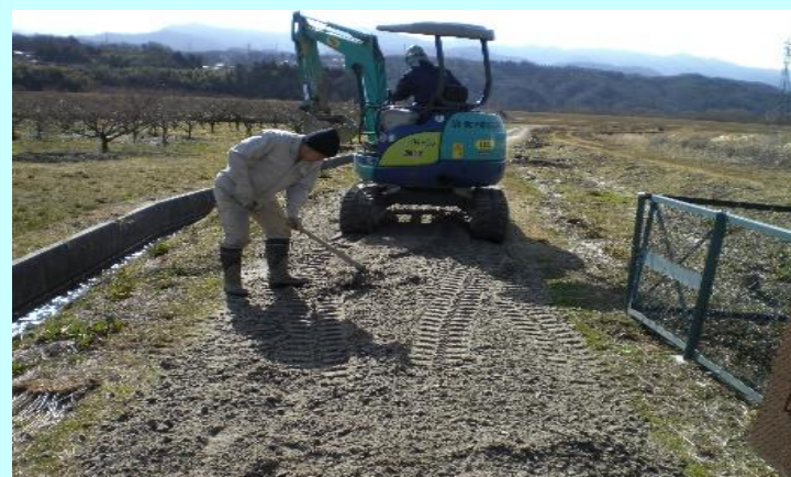
農道補修作業（敷砂利）
