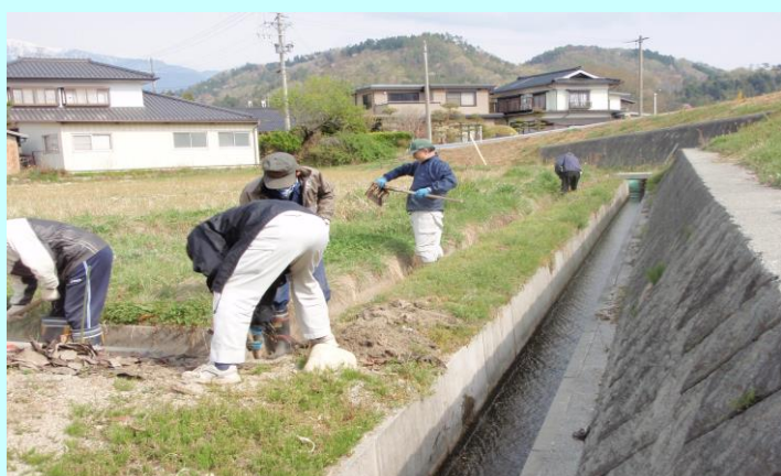
水路の泥出し共同作業
