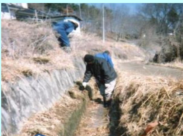
用水路の点検
