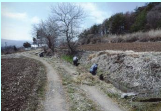
用水路の泥上げ
