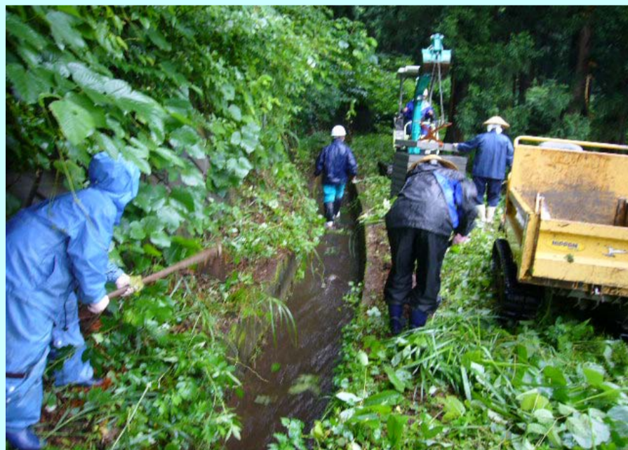
区民総出で用水路の点検及び草刈り、泥等の除去作業を住民協同で実施。
