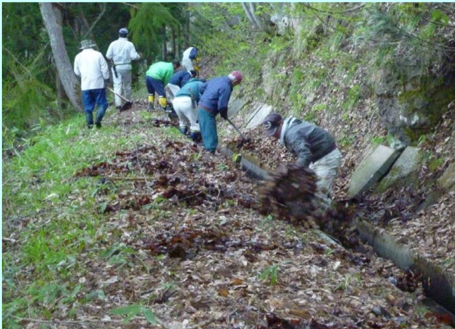
春、耕作期を前に区民総出で用水路の点検及び泥等の除去作業を住民協同で実施。
