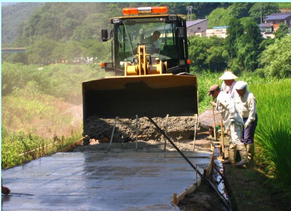
農道の舗装など、自らできることは住民の協同により実施している。
