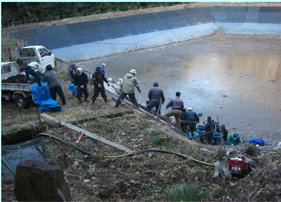
上条地域環境保全会 畑かんファームポンドの泥上げ作業を総出で行います
