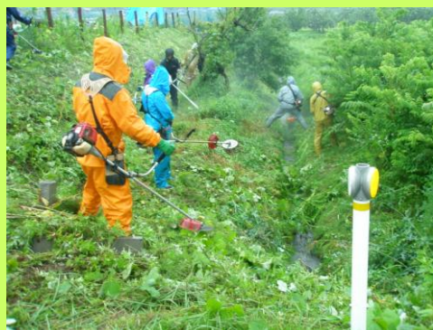
開水路の草刈り・きめ細かな雑草対策
