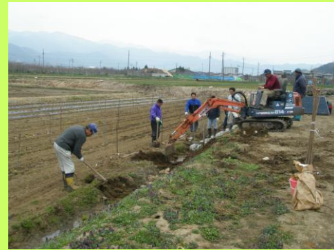
破損施設の修繕
