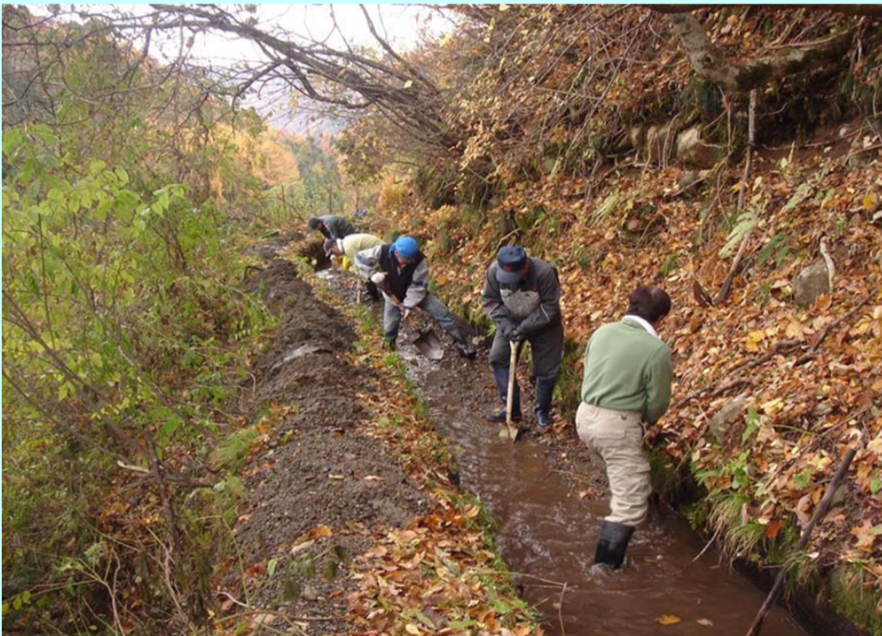
↑ 堰の泥さらい
