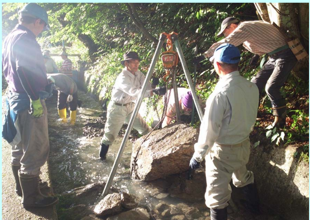
↑ 堰に落ちた巨石の撤去も地域住民で協力して
