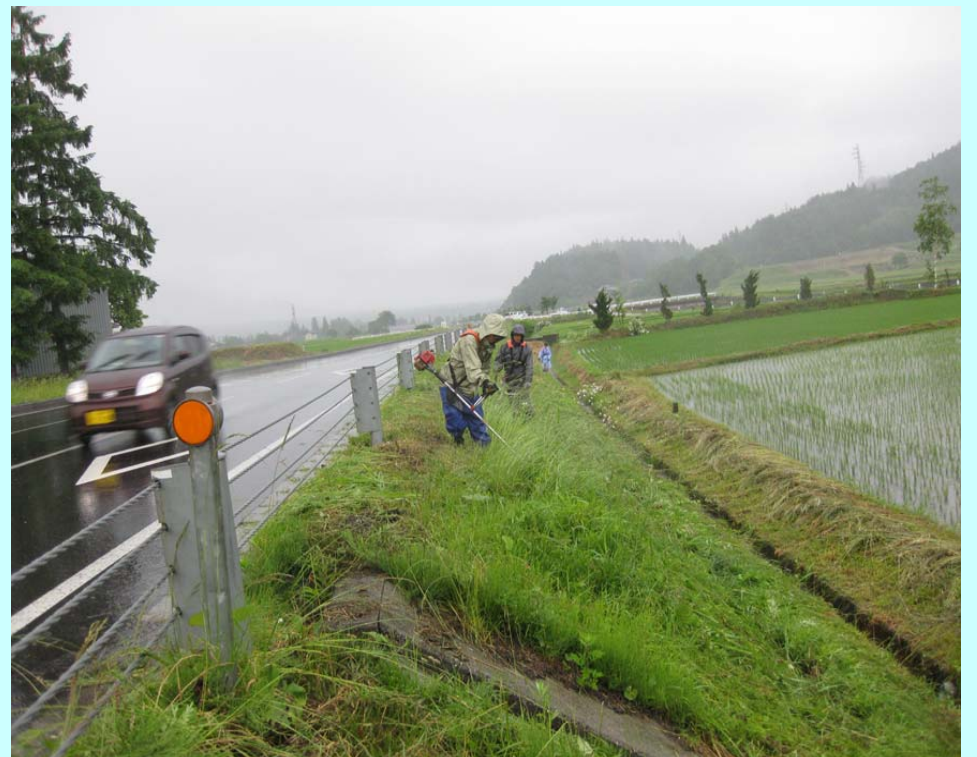
東山農道法面の草刈作業
