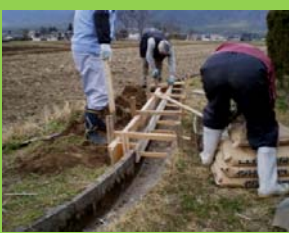
水路補修工事
