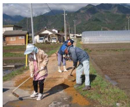
道路補修作業
