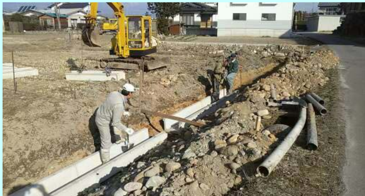
老朽化した水路の布設替え
