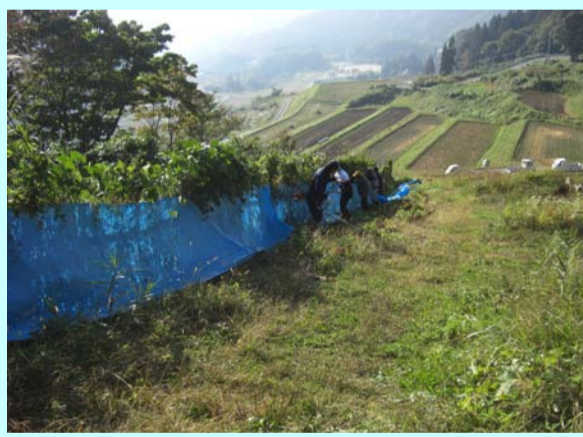
近年増加している鳥獣害防護柵の点検
