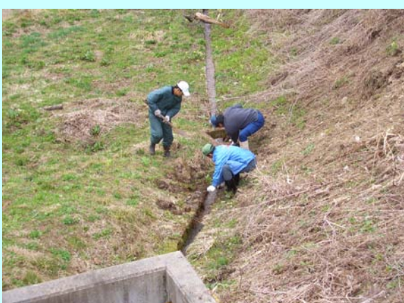
水路の維持・補修作業
