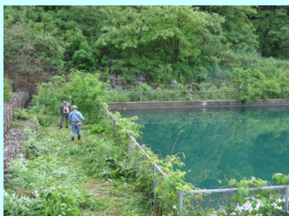
ため池の草刈り・整備
