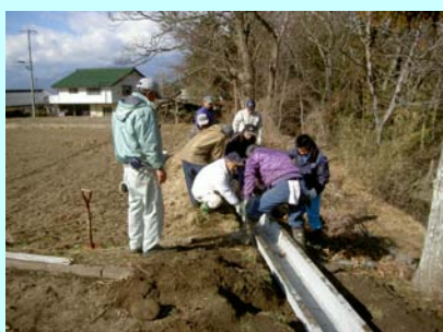
破損水路補修による保安全管理
