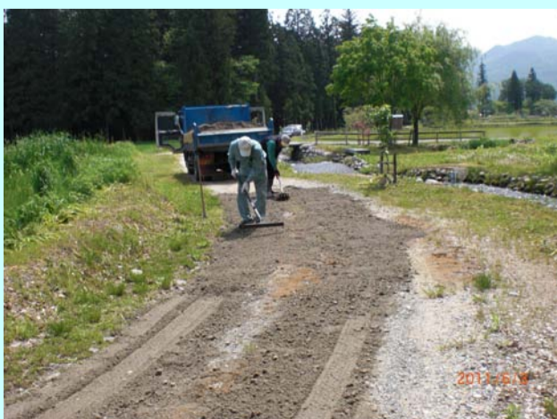
道路補修作業
