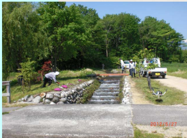
越荒沢堰周辺の草刈り作業
