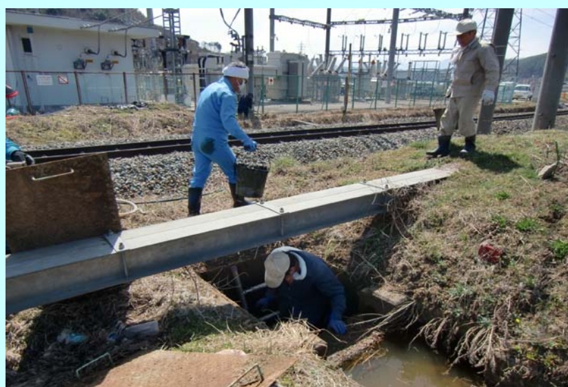
側溝の泥上げ
