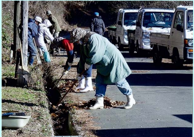
側溝の泥上げ
