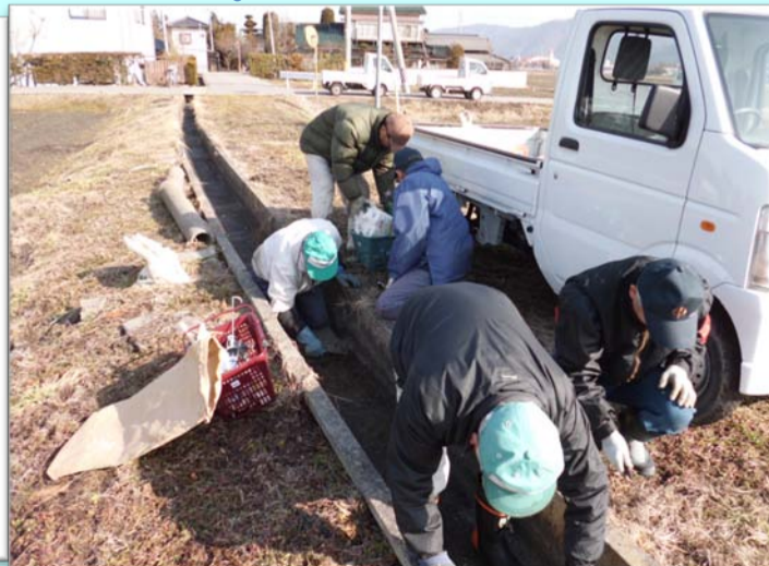
目地修復作業
