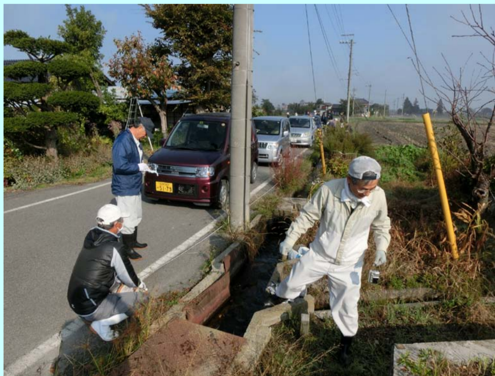
水路の点検・調査
