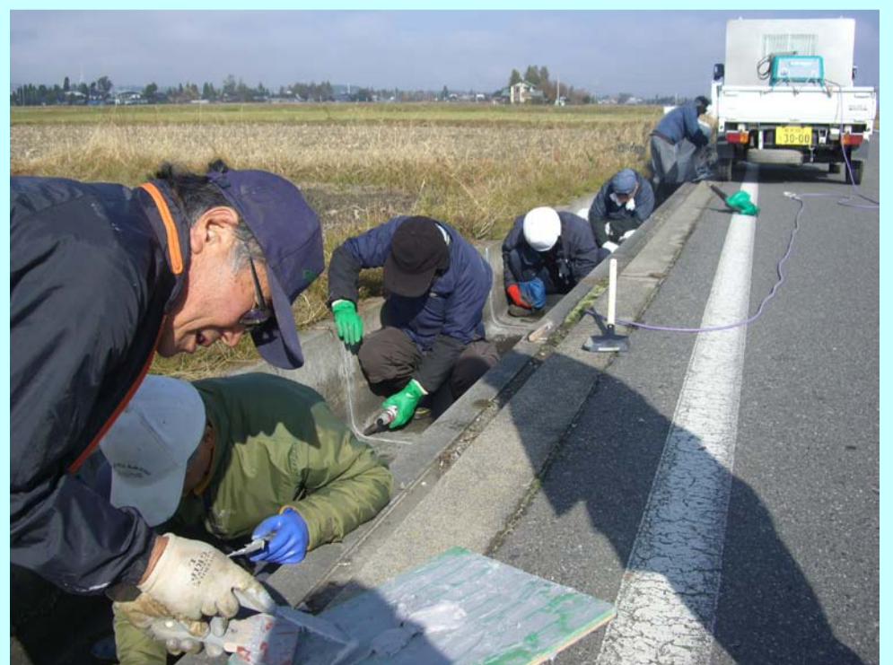
水路の漏水補修作業の様子
