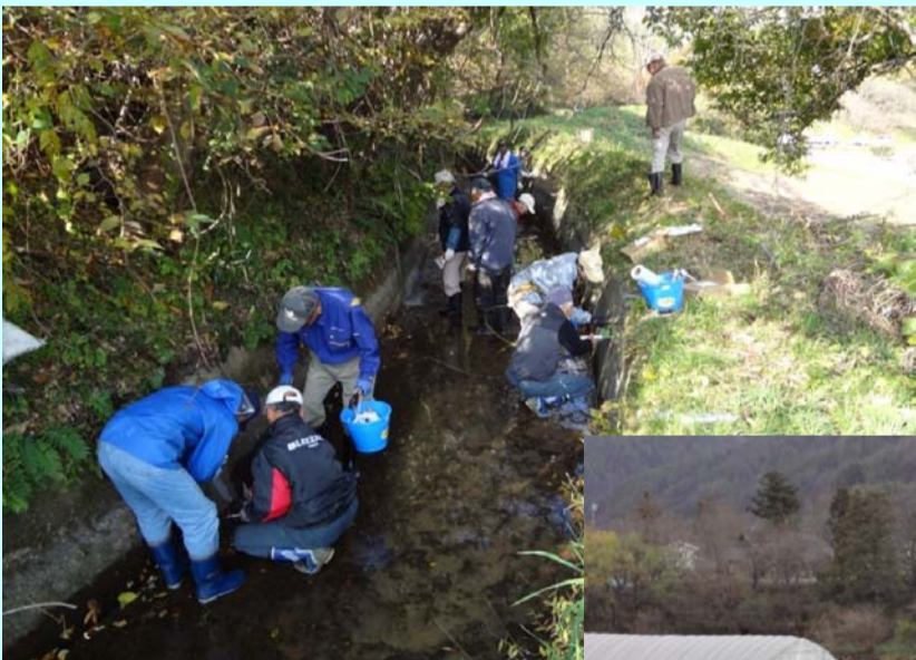
五ヶ用水の補修
